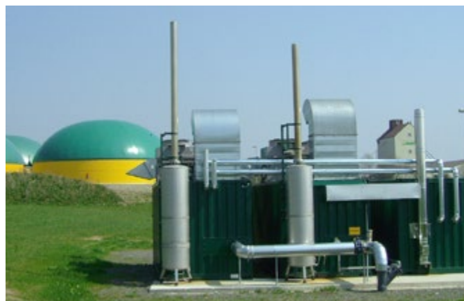
Abbildungen: YADO|KWK Biogas Anlage in Modulbauweise
