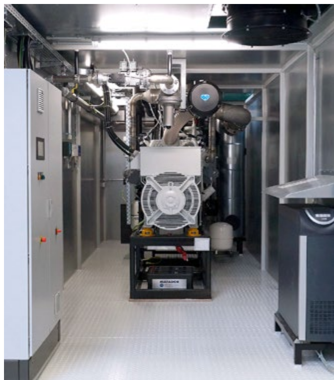
Abbildung YADO|KWK Blockheizkraftwerk im Systemcontainer
