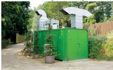
Foto: Blockheizkraftwerk YADO|KWK EG-104, Hotel Bei Schumann
