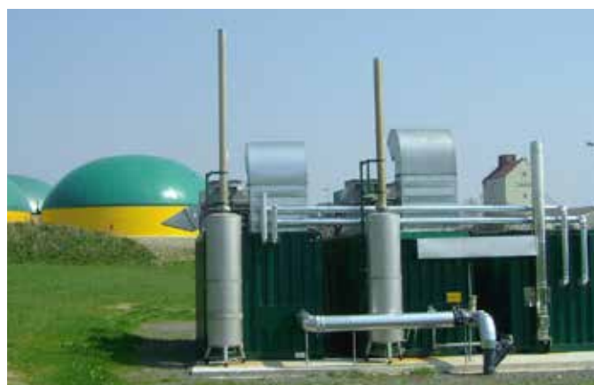
Abbildungen: YADO|KWK Biogas Anlage in Modulbauweise
