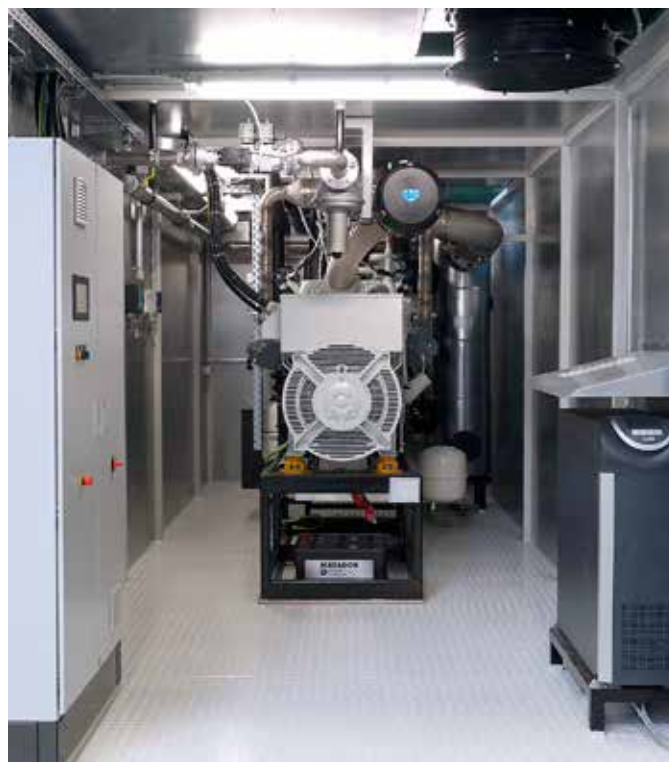
Abbildung YADO|KWK Blockheizkraftwerk im Systemcontainer
