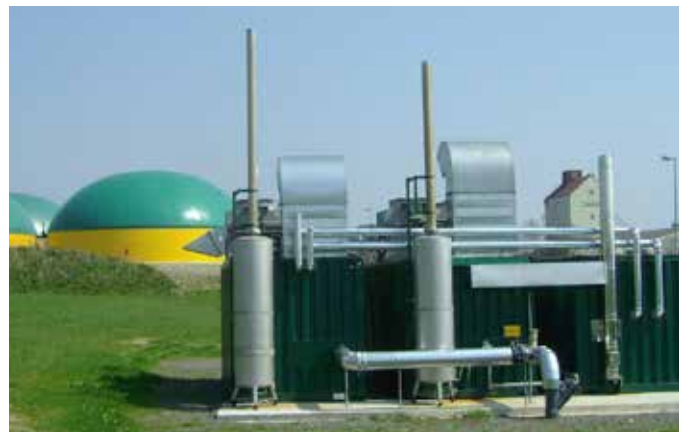
Abbildungen: YADO|KWK Biogas Anlage in Modulbauweise
