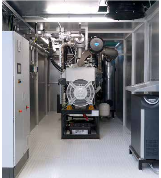
Abbildung YADO|KWK Blockheizkraftwerk im Systemcontainer
